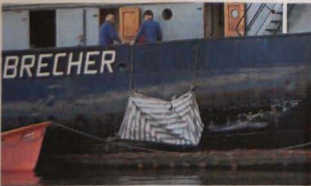
August 2017: Nach der Kollision mit einer Finnland-Fähre kauft ein meterlanger Riss im Rumpf des Eisbrechers „Stettin“. Die genietete Stahlhaut musste von einem Spezialbetrieb repariert werden. Foto: Wüstneck/dpa
